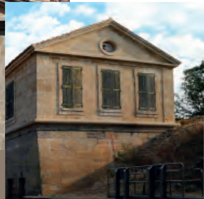
Fig.12 Façade sur pignon de l'épanchoir.
