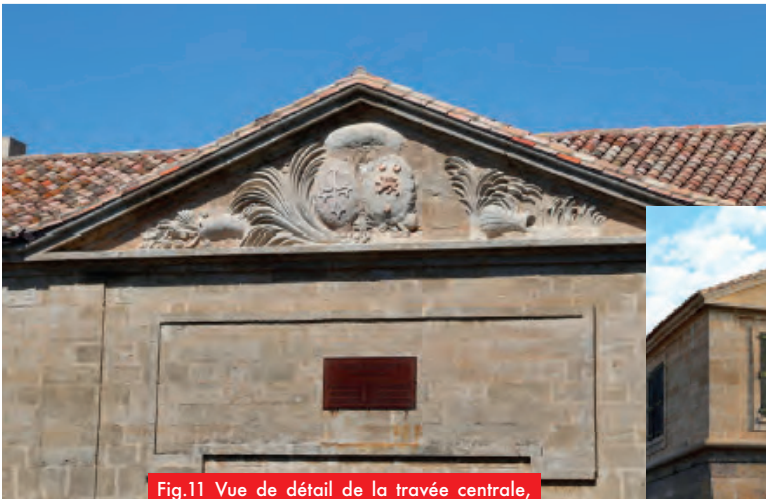
Fig.11 Vue de détail de la travée centrale, côté canal.
